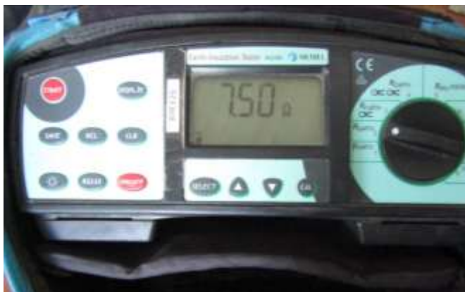
Figura 4. Resistencia puesta a tierra medida por telurómetro.
